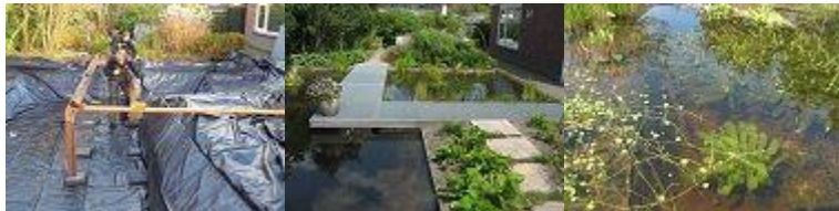
Pad door de vijver: tijdens aanleg en na realisatie
